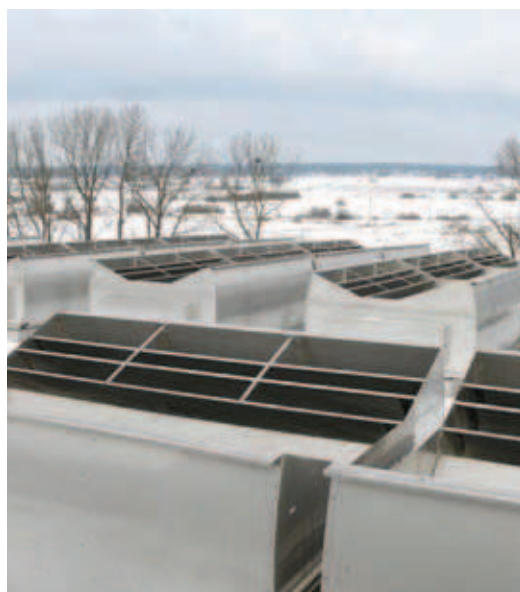
Fot. 2 Wywiewniki na dachu już zamontowane
