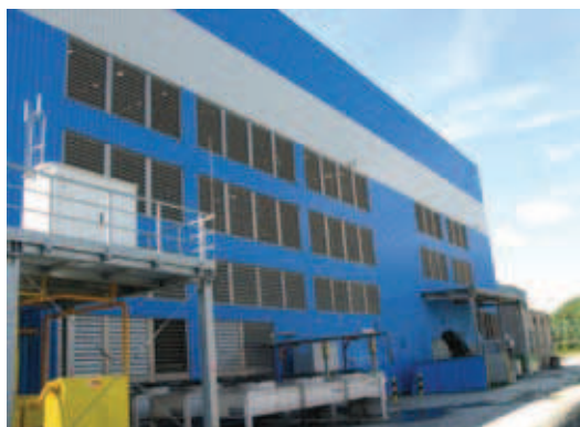
Fot. 3 Minimalizacja podciśnienia wymaga odpowiednio dużej liczby czerpni
