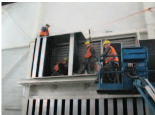
Fot. 4 Montaż tłumików akustycznych na czerpniach ściennych żaluzjowych
