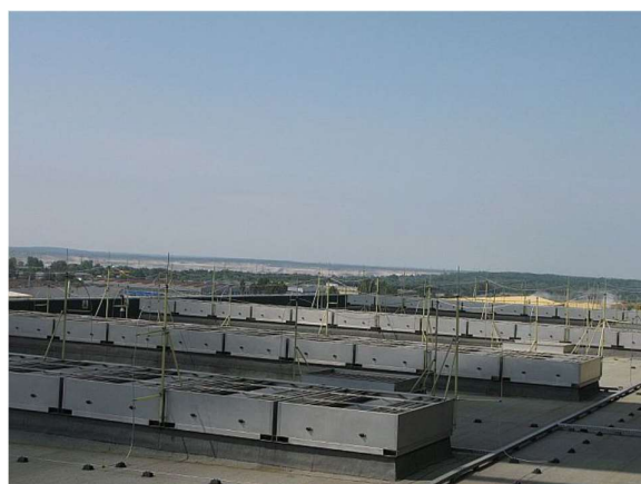
Elektrownia Bełchatów - Hala maszynowni
